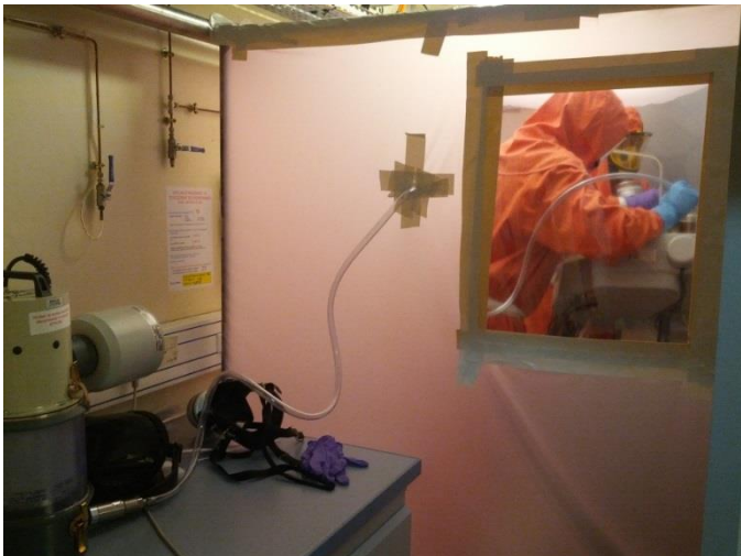
Remplacement du multitrous
