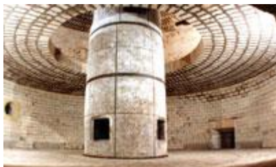
Revêtement pour les incinérateurs de déchets ménagers en oxyde de zirconium. Secteur de l'Environnement
