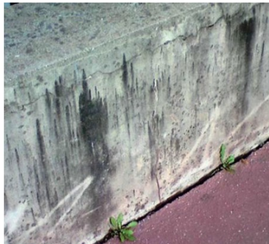
Exemples de prolifération à base d'algues et de champignons recouvrant des murs en béton
