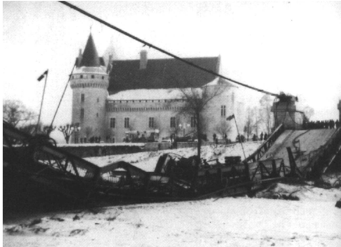
rupture d'un câble de soutien du pont de Sully-sur-Loire durant l'hiver 85, ayant entraîné la chute du pont
